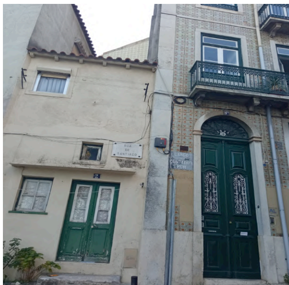
Fig. 6: Placa designativa da Rua de Santiago em Lisboa
